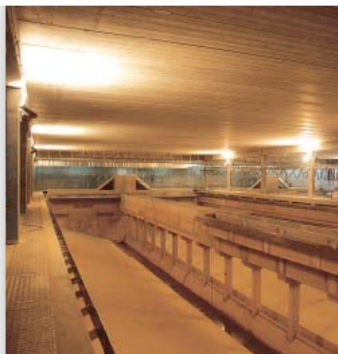
▲ Station d'épuration de Bonneuil.
