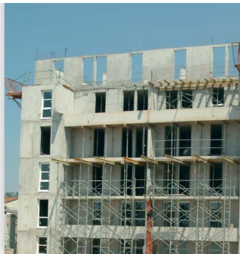
Constructie van een appartementsgebouw
