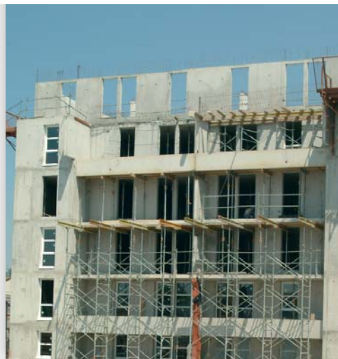
Construction d'un immeuble d'habitation
