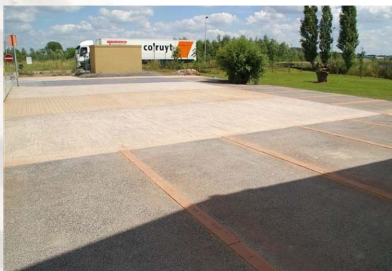
▲ Parking van de betoncentrale te Ghislenghien
