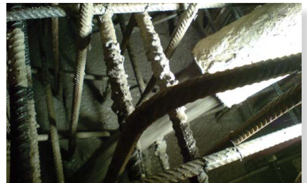
▲ Coulage du béton en sortie de pompe
