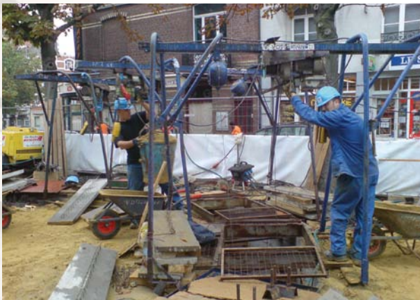
▲ Un puits d'entrée
